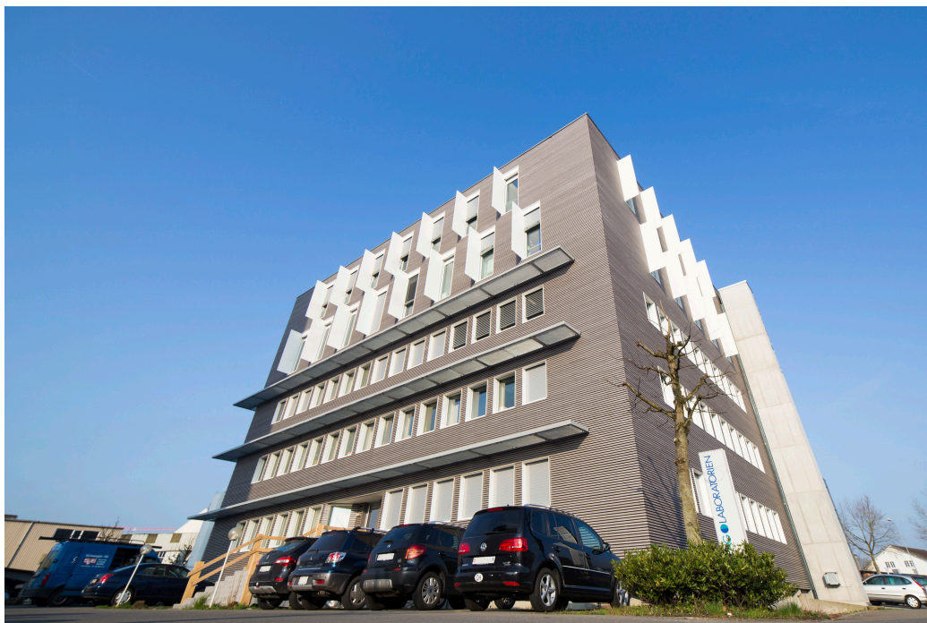
Platz für weiteres Wachstum: das renovierte und aufgestockte Laborgebäude Süd der UFAG Laboratorien AG.
